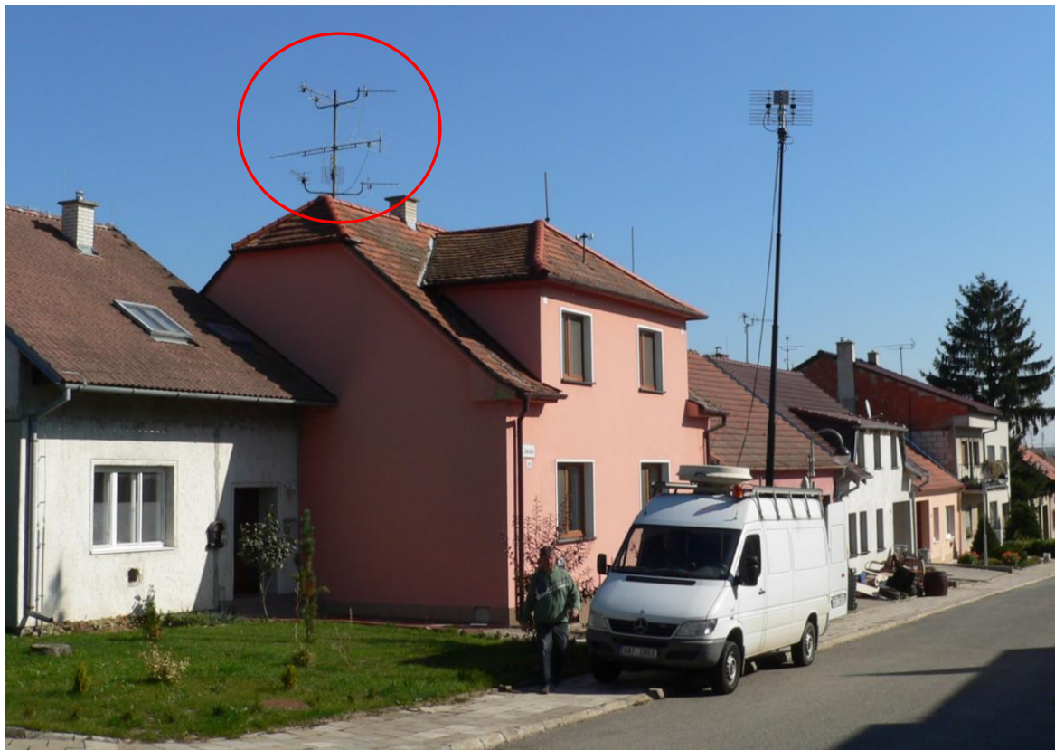
Anténní systém na RD Zahradní 60, měřicí vůz při srovnávacím měření
