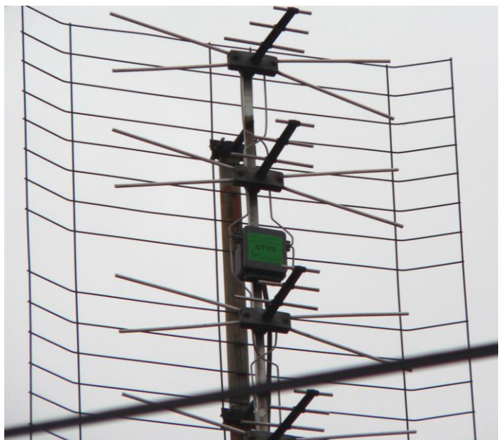
Detail antény s předzesilovačem
